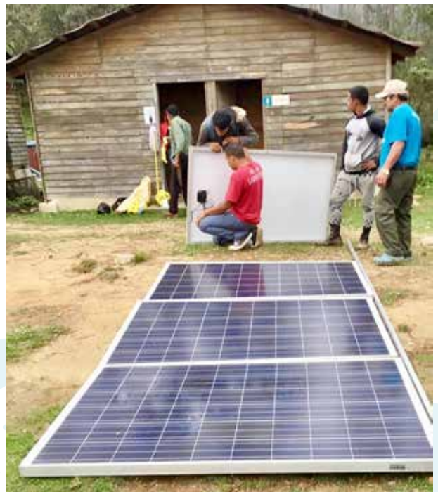
Colocación de paneles solares.
